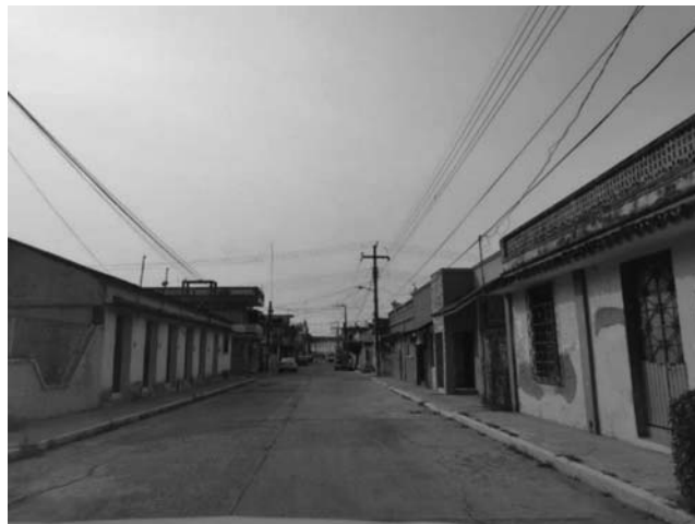
Figura 76. Tipología de vivienda.
